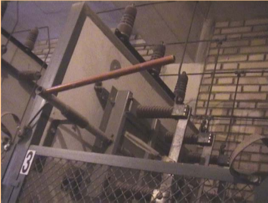
Seccionador e Interruptor en celda entrada MT al aire (antiguas)
