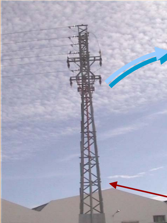
Fig.2 – Paso Aérea-Subterránea y poste hormigón
