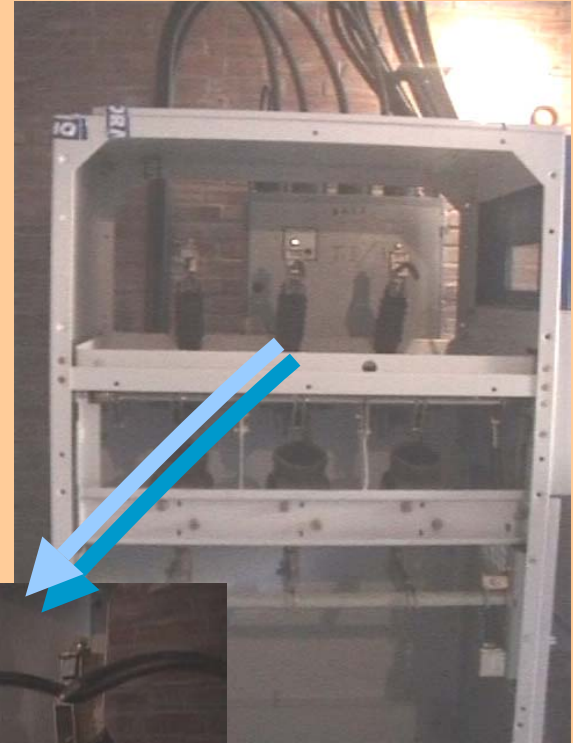
Celdas entrada desnuda y detalle seccionador
