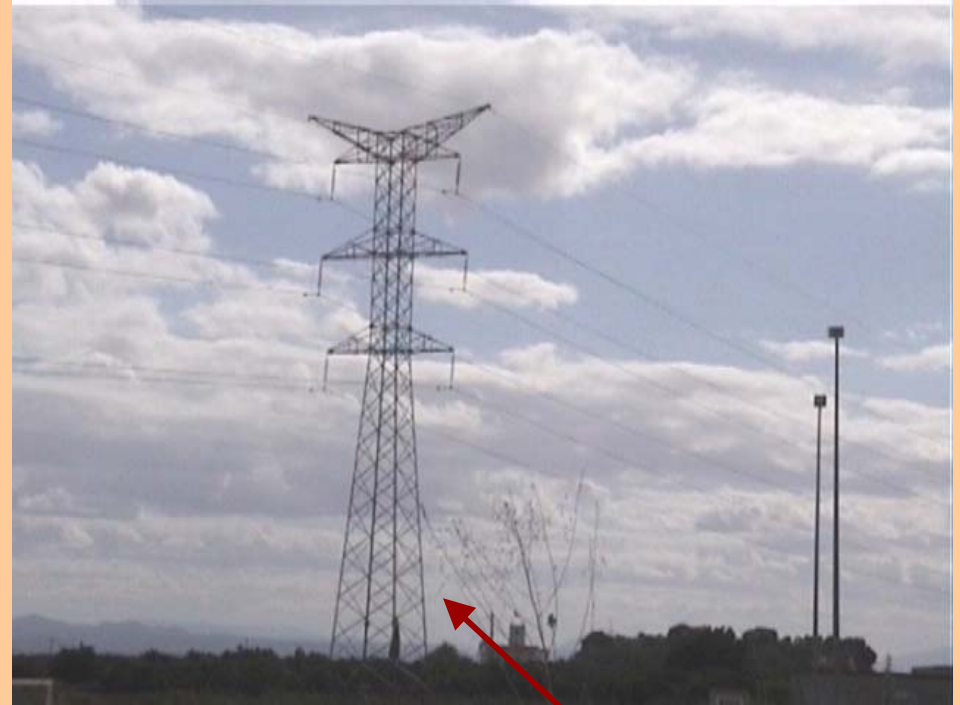
Fig.2 – Postes metálicos celosía y presilla
