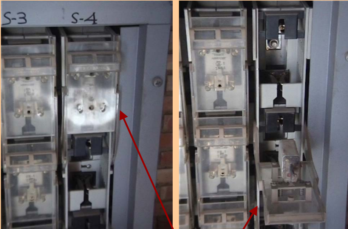
Seccionador cuadro BT cerrado y abierto
