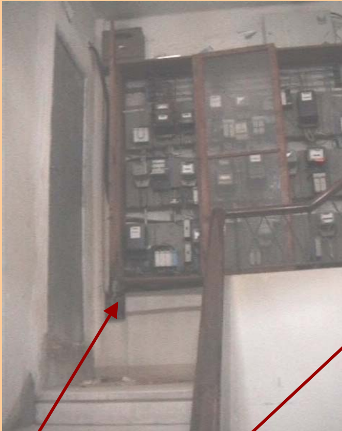
Fig.1 – Centralización de Contadores en alto escalera y zaguán
