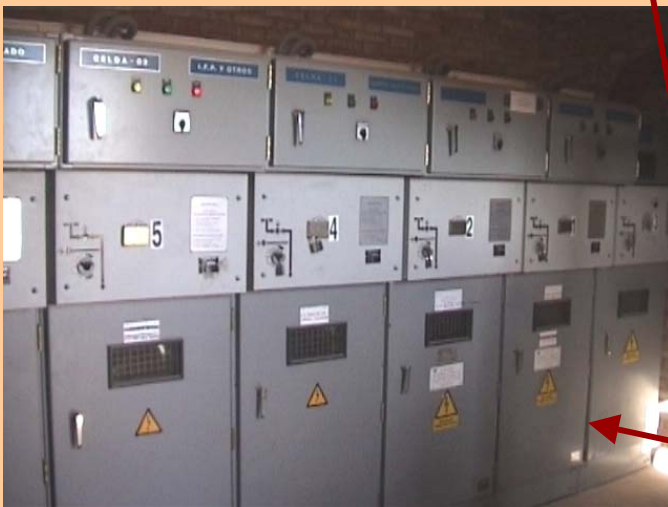
Celdas entrada sin motorizar y motorizadas
