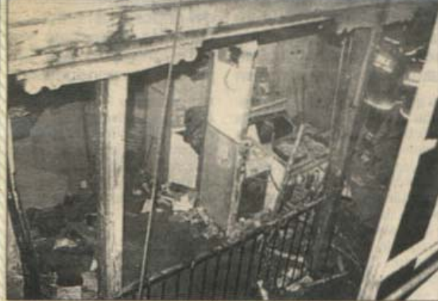
Estado en el que quedó el edificio.
