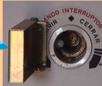
Mando seccionador e instrucciones
