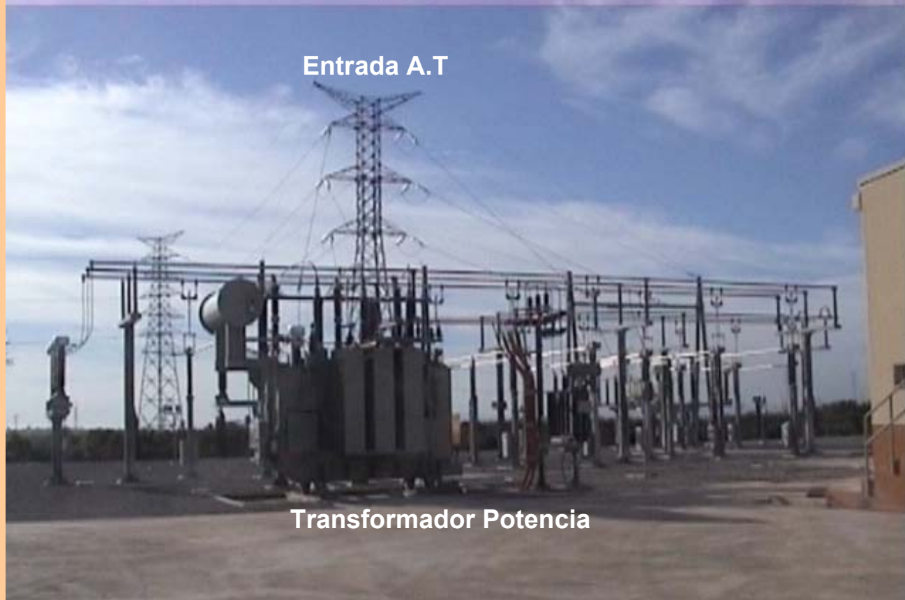
S.T Transformación 132 KV / 20 KV
