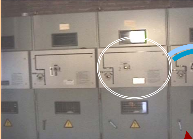
Mando seccionador e instrucciones
