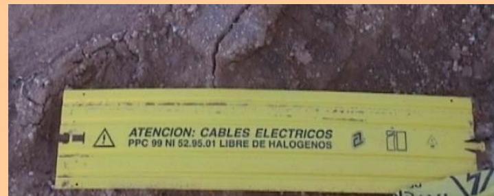
Fig.5 – Señalización cables enterrados
