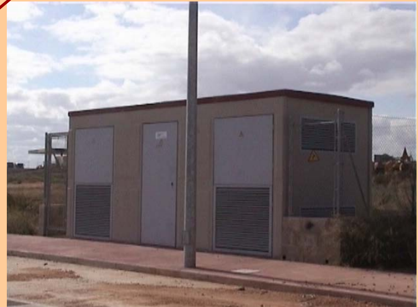
CT prefabricado
