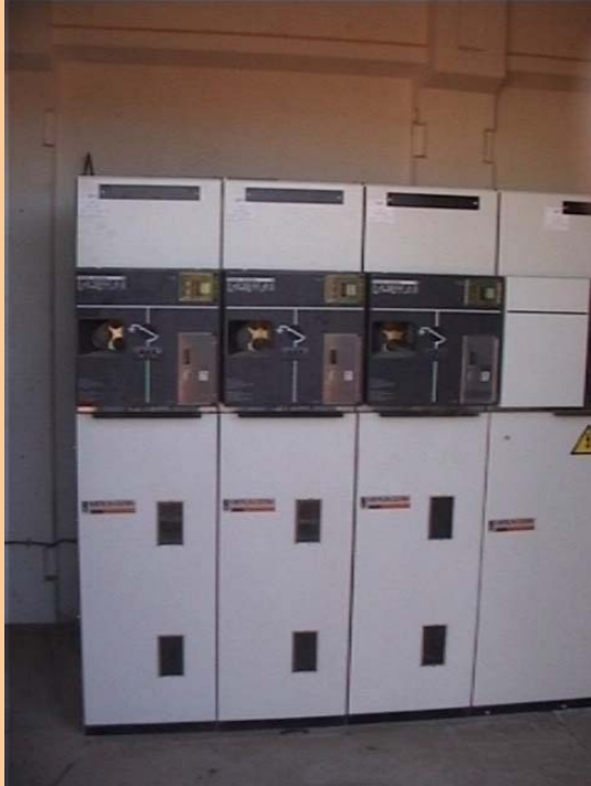
Celdas entrada hexafluoruro
