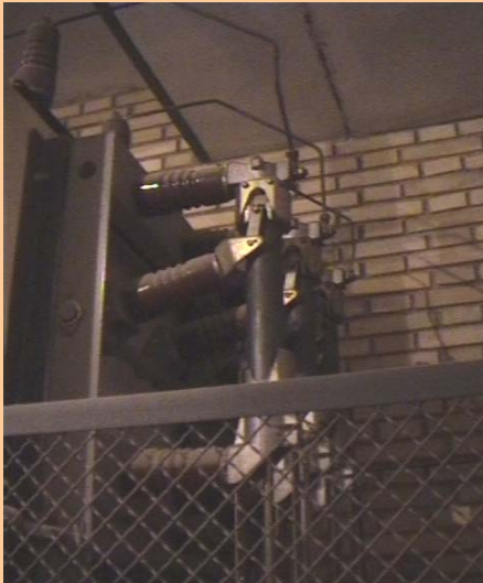
Seccionador e Interruptor en celda entrada MT al aire (antiguas)
