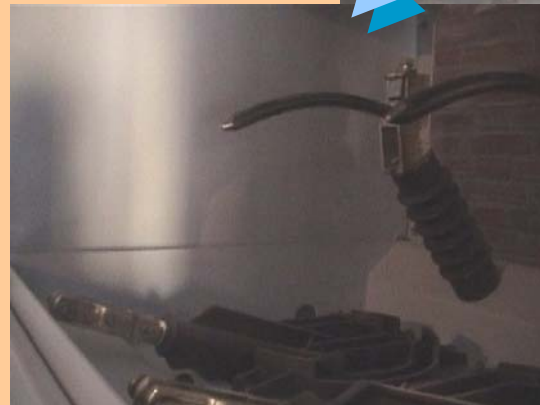
Celdas entrada desnuda y detalle seccionador
