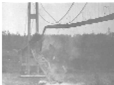
Fallo del puente al entrar en resonancia
