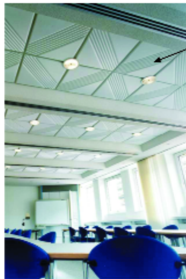
Ejemplo de la aplicación de un material absorbente para el acondicionamiento de una sala de conferencias (aplicación en el falso techo).
