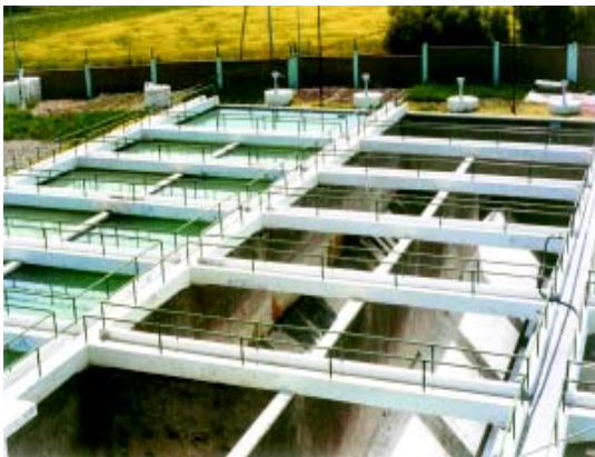
Figura 3-2. Decantador de vuelta en U (3)
