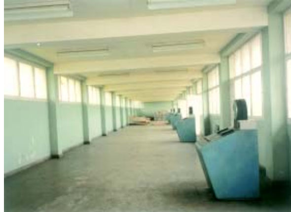
Figura 3-12. Galería de operación de los filtros (3)
