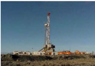
Perforación de Pozos
